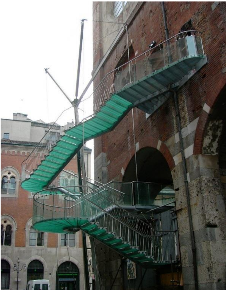
Fig. 1-5 restauro del Palazzo della Ragione a Milano
