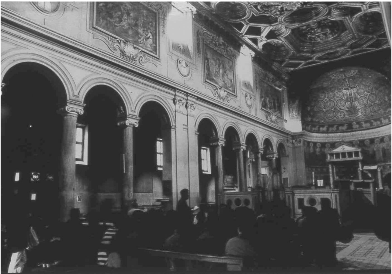
Fig. 5 Restauro di San Clemente (1715 c.), opera di Carlo Stefano Fontana: Restauro di sola decorazione (soffitto, pilastri in stucco, dipinti); rispetto del pavimento cosmatesco (XII sec.) e della schola cantorum (XII sec); rispetto della pianta con colonne e pilastri.
